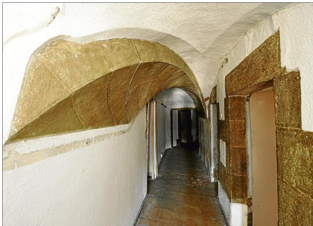
L'arc rebaixat sobre el corredor de l'entresòl és l'element arquitectònic més remarcable
